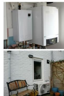
Figuur 11: Hybride warmtepomp en gasketel (boven), buitenunit (onder)
