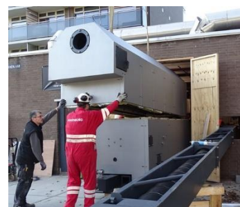
Figuur 12: Plaatsing van collectieve biomassaketel, Vlaardingen (Waterweg Wonen)
